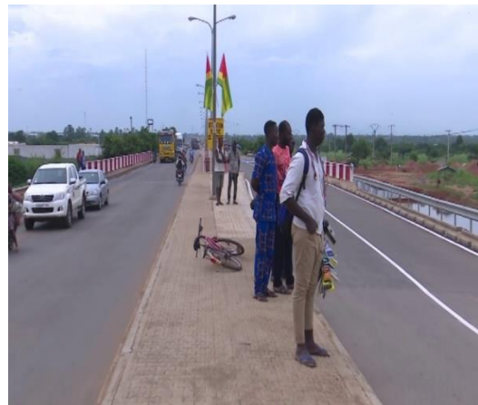
Photo n°4 : Voie du contournement
